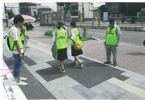
アスファルトで埋められ、点字ブロックが途切れている歩道(春山1丁目)
